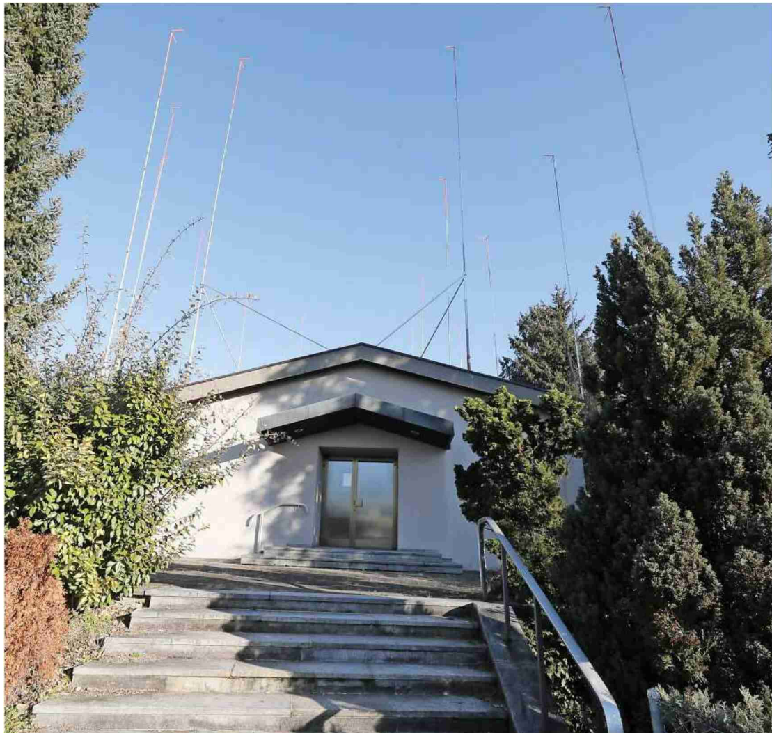
Bis vor einem Jahr haben hier die Gottesdienste der Neuapostolischen Kirche Kloten stattgefunden. Nun liegt das Baugesuch für ein Wohnblock vor. Foto: Paco Carrascosa
